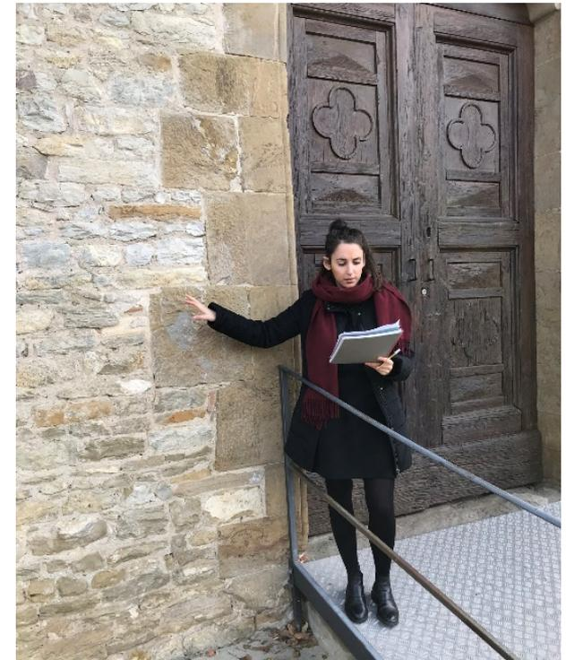
*L'alberese invece è una roccia calcarea formatasi dall'accumulo di sedimenti di varia origine; in base alla quantità di minerali argillosi le pietre presentano delle venature, il cui colore si modifica con il passare del tempo. Queste venature sembrano degli alberelli: ecco, forse, da dove deriva il significato del termine "alberese". La campagna sembra quindi rispecchiarsi in questa chiara facciata.*
